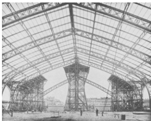
[Fig.6] Construction of the Galerie des Machines, Paris, 1889. Archiv S. Giedion, Institut für Geschichte und Theorie der Architektur, ETH – Honggerberg, Zurich.
