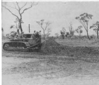
• Prosseguem os serviços de terraplenagem e nivelção de áreas.
