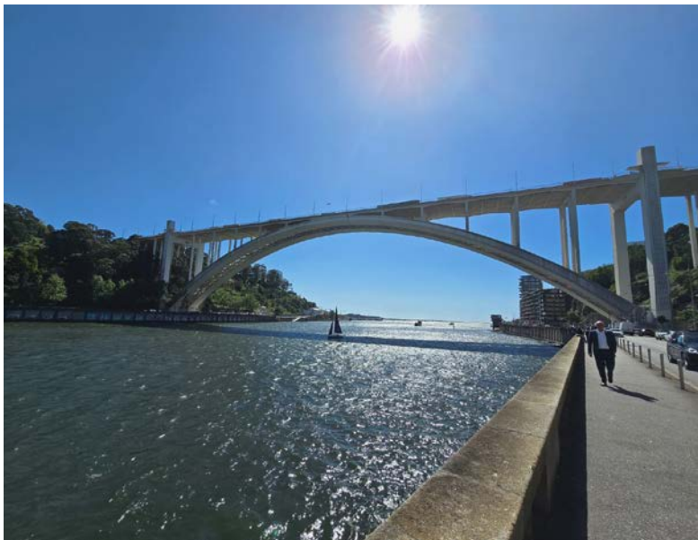
Figura 4. Vista da Ponte da Arrábida antes da construção da Ponte da Ferreirinha, coleção pessoal (Fontoura, 2024).
