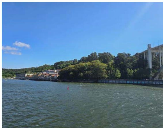
Figura 5. Vista da parte oriental da Ponte da Arrábida e da implementação da Ponte da Ferreirinha, coleção pessoal (Fontoura, 2024).
